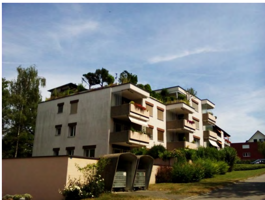
Рис. 3. Жилое здание в городе Берикон (Швейцария)
